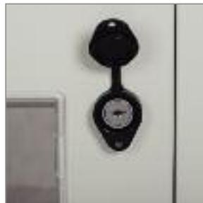
Возможность пломбировки учетного отсека (с помощью накладки на замок).
